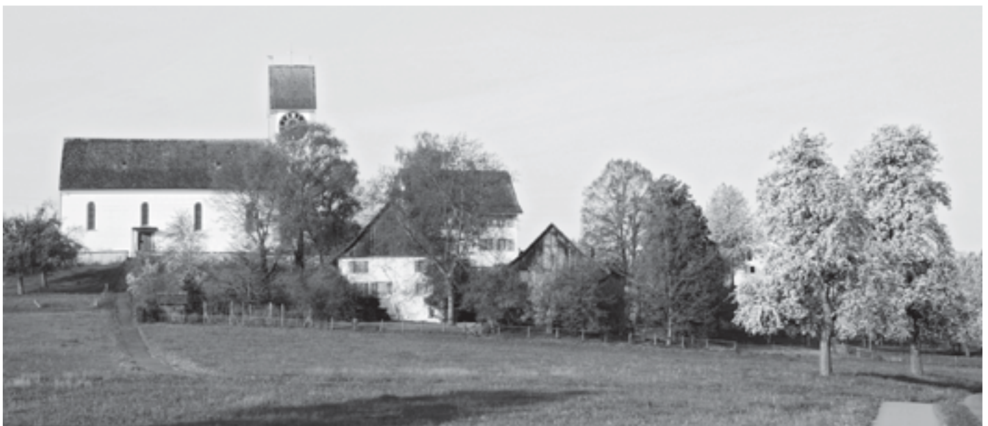
Das Wohnhaus des damaligen Lehrers Bebi diente von 1736 bis 1825 zugleich als Oetwiler Schulhaus.
