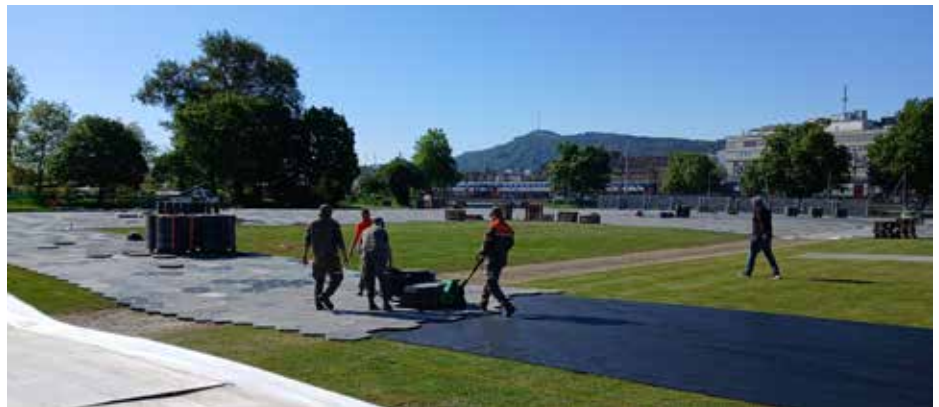
Der Boden musste geschützt werden. Insgesamt wurden über 15'000 m 2 Bodenschutz verlegt.
