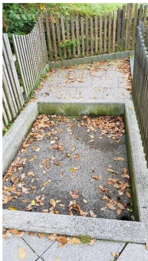
Abbildung 9: Durchschreitebecken am Eingang zur Rutschbahn
