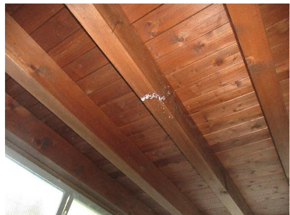
Abbildung 7: Untersicht Holzschalung Dach
