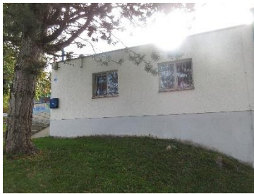
Abbildung 3: Massivbau wird zurückgebaut
