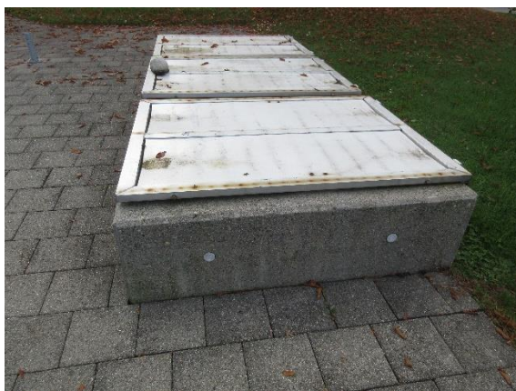
Abbildung 16: Bestehender Schieberschacht
