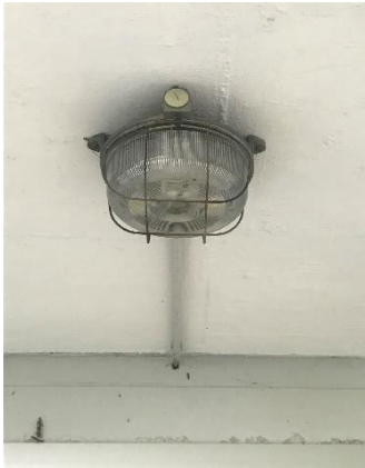
Abbildung 44: Aussenleuchte Technik
