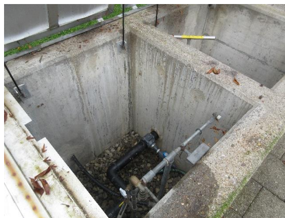
Abbildung 17: Innenansicht Schieberschacht
