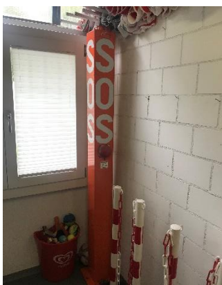
Abbildung 55: Provisorische SOS- Säule
