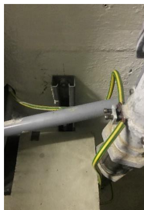
Abbildung 41: Anschlussklemmen
