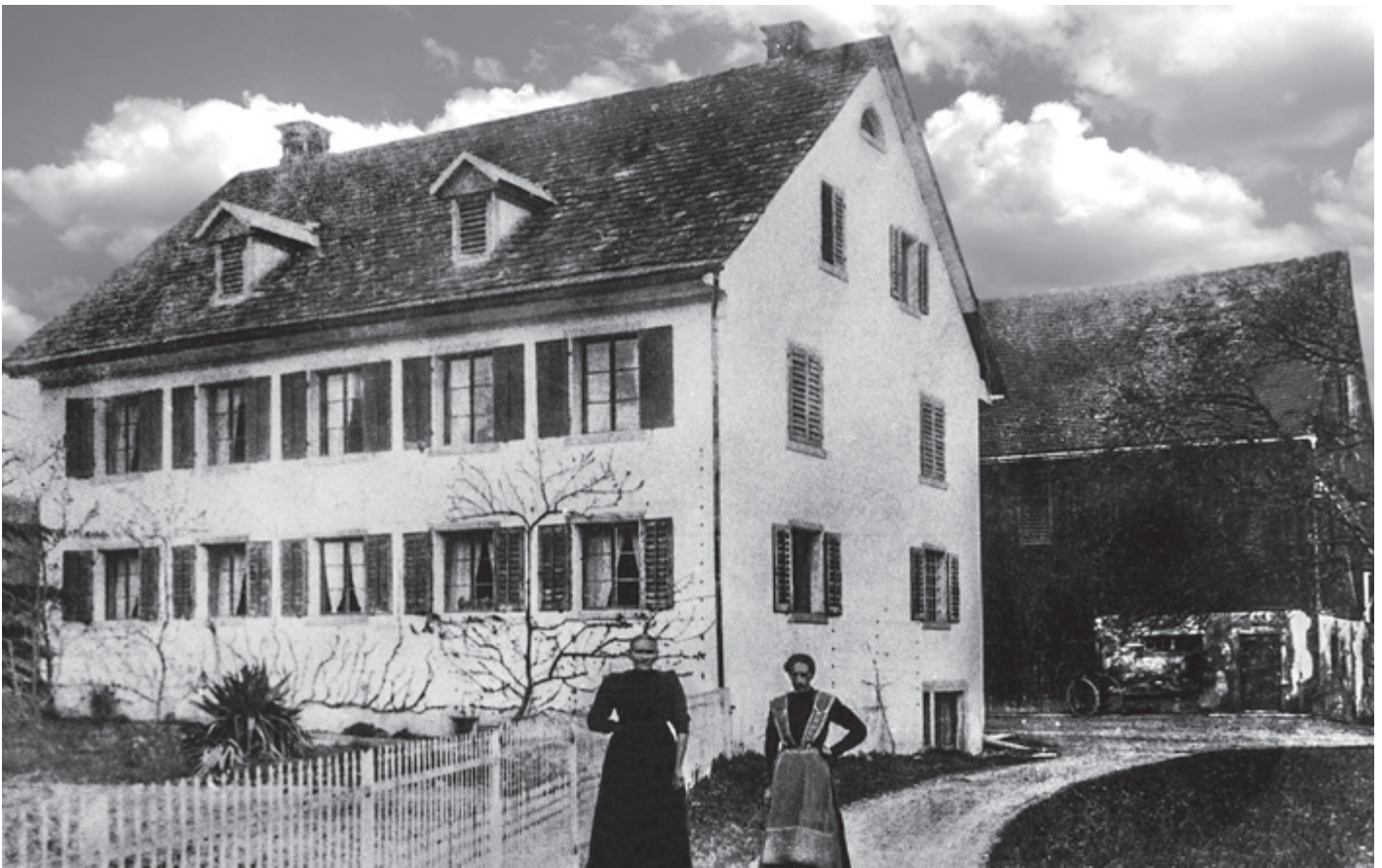
Das nach dem Brand von 1831 neuerbaute Fabrikhaus mit kleiner Wohnung. 1851 wurde es ganz als Wohnhaus genutzt. Foto aus den 1920er Jahren.
